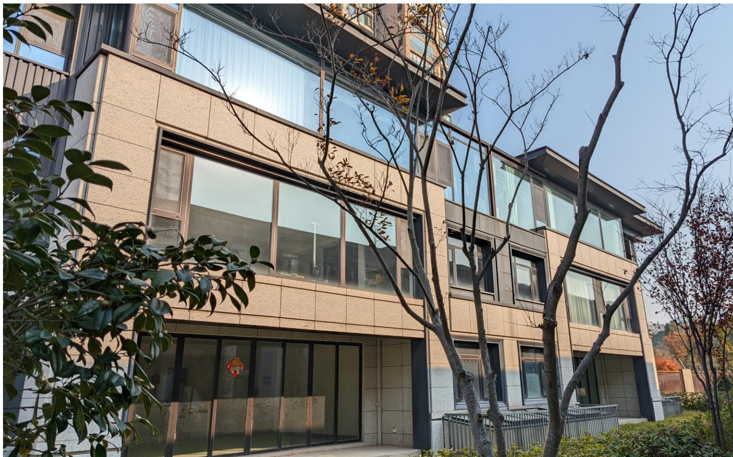
无锡金科蠡湖一号平层（改造项目）
